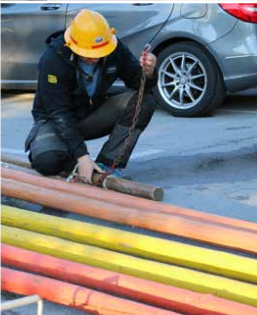
Osnovno orodje za postavljanje so dolge palice, ki jim pravimo latene in piki
