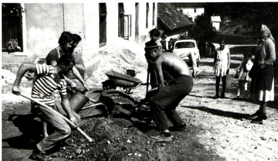
BETONIRANJE PRI OBNOVI KULTURNEGA DOMA ARHIV PETRA LAMPIČA
