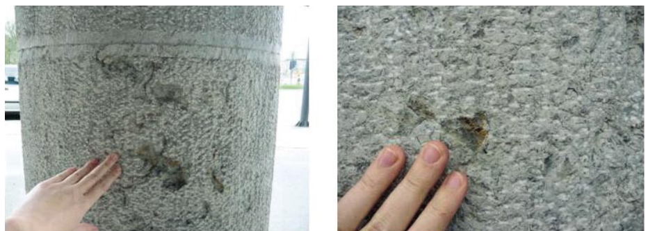
Slika 5 • Izpadanje kosov – levo: izpadanje v večjem obsegu; desno: izpadanje v manjšem obsegu
