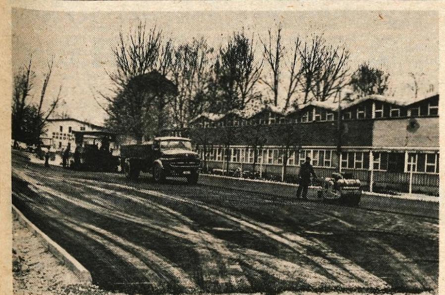
Te dni delavci Komunalnega podjetja iz Ljubljane urejajo parkirni prostor in dvorišče ob Gorenjski predilnici v Škofji Loki. Asfalt bodo položili na površini okrog 2000 kvadratnih metrov, celotna investicija pa bo znašala približno 200.000 din. Vsa dela bodo končana do sredine prihodnjega tedna. (jg) — Foto: F. Perdan
