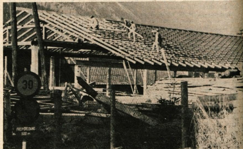
Delavci SGP Sava Jesenice grade vzhodno od bencinske črpalke na Plavžu na Jesenicah novo halo, v kateri bodo njihovi tesarji lahko delali ob vsakem vremenu. Hala, ki bo predvidoma na red do novega leta, bo vsekokor pridobitev glede varstva pri delu, saj bodo pod njeno streho tesarji zaščiteni pred dežjem, snegom in mrazom. Razen tega pa bodo s tem podani tudi boljši pogoji za večjo storilnost. — B. B.
