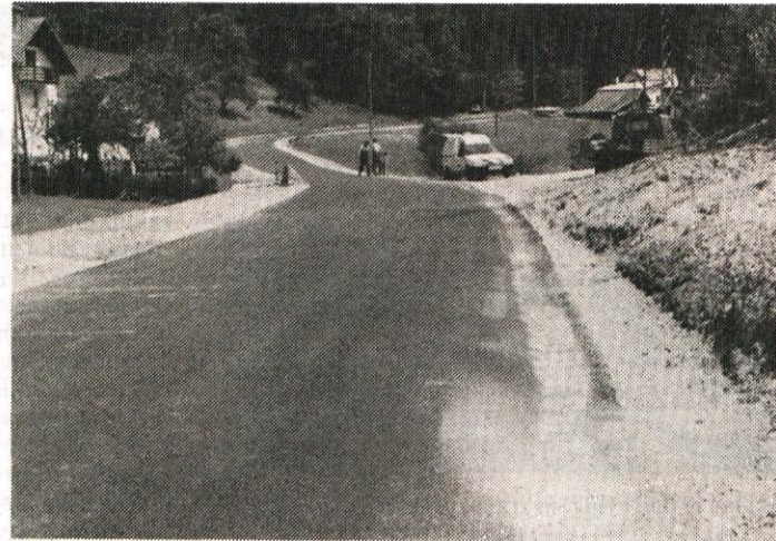
Cesta Stranska vas - občinska meja asfaltirana — Cestni odsek Stranska vas pri Dobrovi - občinska meja je naposled le prekril asfalt. Tako je v celoti asfaltirana cesta Dobrova-Podutik, ki jo vozniki iz polhograjske in horjulske doline ter Dobrove uporabljajo kot bližnjico. Del ceste pred Stransko vasjo je zaščiten tudi s kamnito škarpo. Delavci Cestnega podjetja Ljubljana, ki je cesto uredilo, zdaj opravljajo še končna dela ob cesti. (B. V.)
