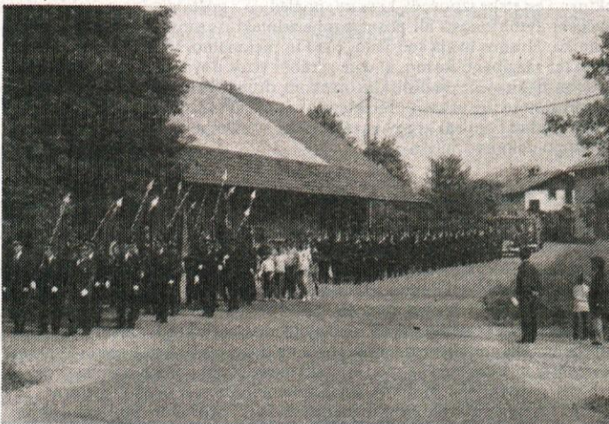
Pogled na gasilsko paradno, ki je šla skozi Sinjo Gorico.
