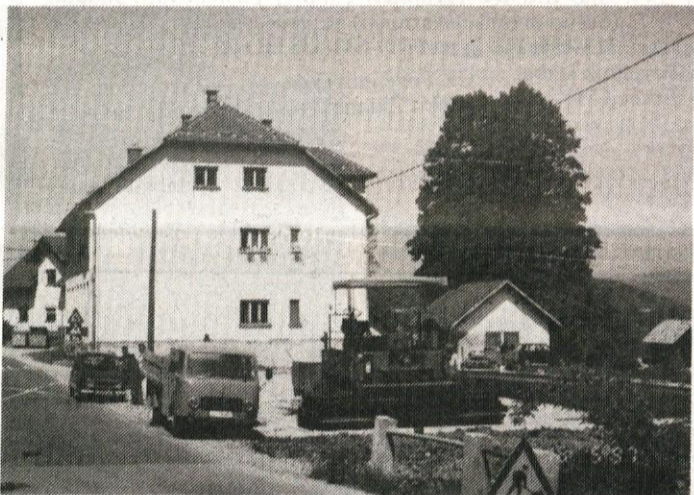
Asfaltiranje igrišča pri šoli na Jezeru in....
