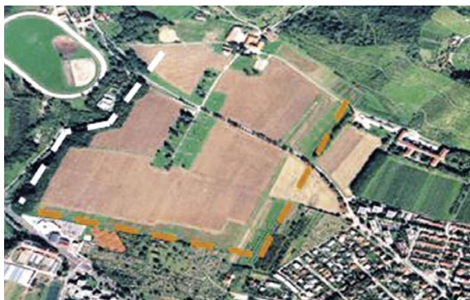
Slika 1 • Črpališče regionalnega mariborskega vodovoda na Vrbanek plateau, ki oskrbuje z vodo 17 občin in 200.000 prebivalcev. Linije infiltracijskih vodnjakov za bogatenje podtalnice na vzhodni strani črpališča še čakajo na izvedbo
