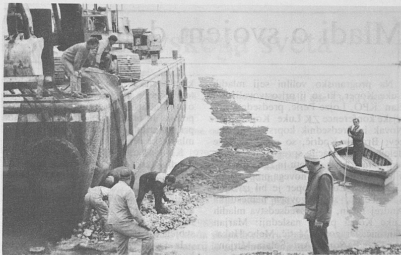
Delavci »Gradisa« pripravljajo teren, na katerem bo zgrajena podaljšana kontejnerska obala
