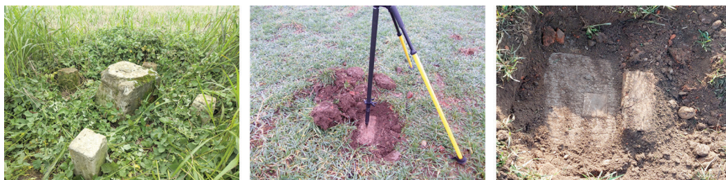
Slika 4: Nekdanja stabilizacija sredinske točke 225 (foto: D. Vantur, 2020; levo), stanje tik pod površjem po njenem uničenju (sredina) in njen podzemni center na globini 30–40 centimetrov (desno) (vir: GURS, foto: R. Škafar, 2023).
