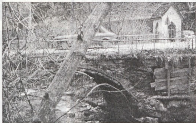
Kamniti, tu in tam že z betoni zaplombiran most na Vuhreščici
