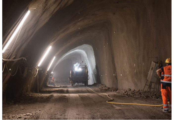
Slika 5. Stabilizacija leve kalote na južni strani predora z brizganjem betona, maj, 2022.
