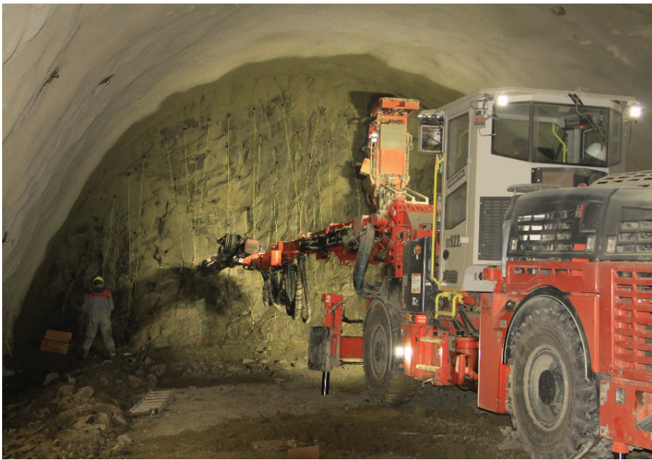
Slika 6. Vrtanje minskih vrtin v predoru na severni strani, november, 2021.
