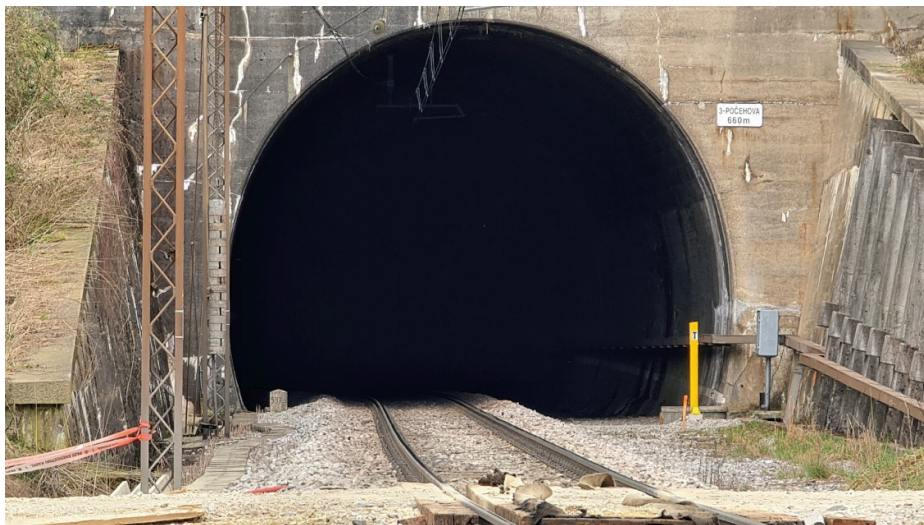
Slika 2. Predor Počehova na obstoječi železniški progi.
