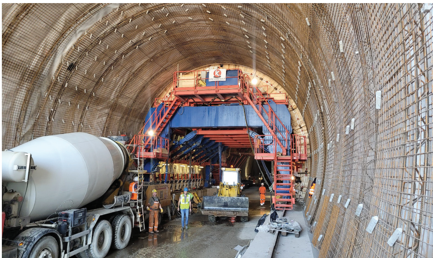
Slika 1. Gradnja predora Pekel na severni strani, september 2022.
