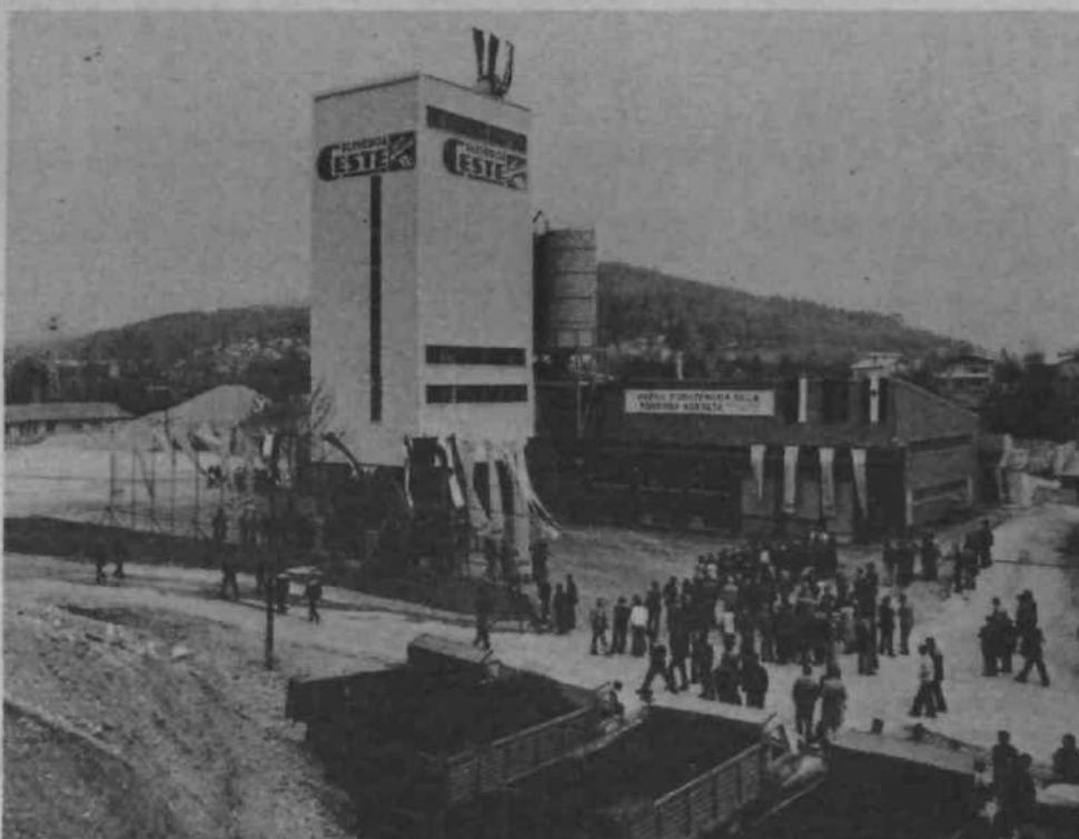
Za komandnim pulvom tovarne asfalta SGP Slovenija ceste na Črnučah bosta le dva delavca. S pritiski na gumbe bosta obvladala proizvodnjo 300 ton asfaltne mešanice na uro.
