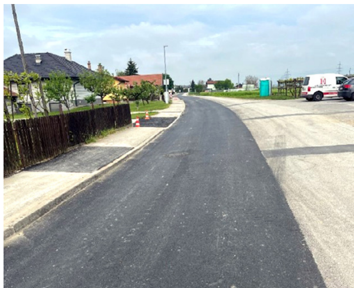
Izgradnja kanalizacije v Lancovi vasi
