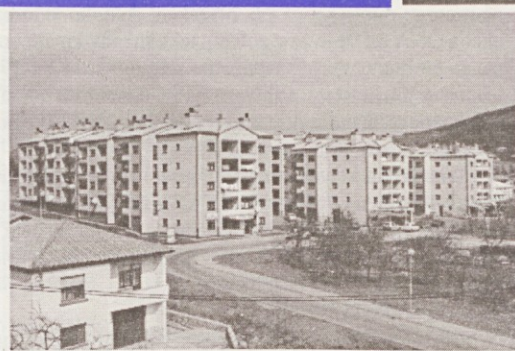
Ilirska Bistrica Poslovno-stanovanjski objekt - S20 - manjši poslovni prostori - dvojnopolno stanovanje
