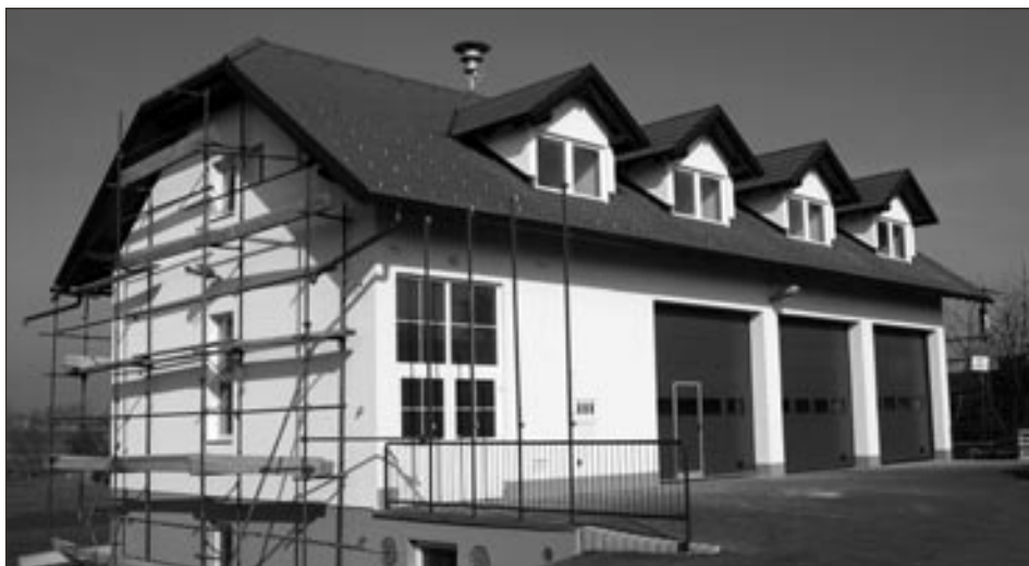
Pogled na fasado doma
