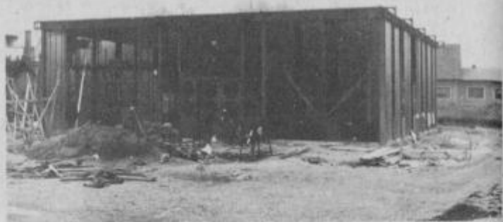
Novo avtopralnica in tehnična kontrolna delavnica SIGME
