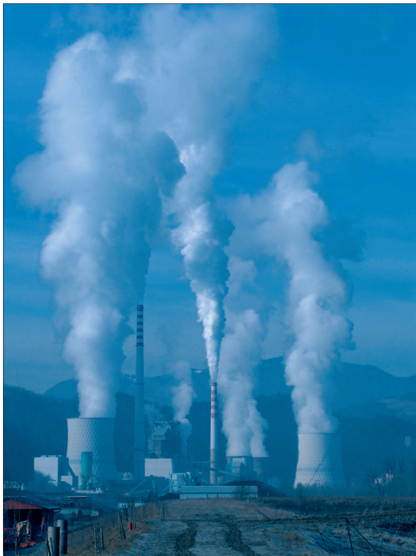
Slika 3: Termoelektrarne in toplarne postajajo večji uporabnik lesne biomase
