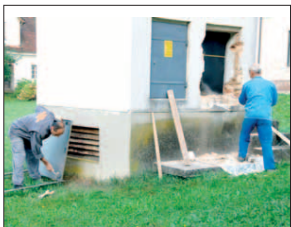
Odstranjevanje zarjavelih vrat na transformatorski postaji ZD Horjul
