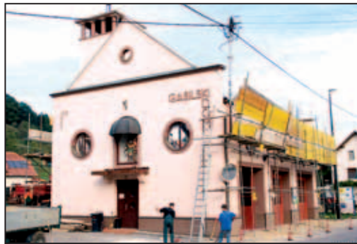
Z gasilskega doma so že odstranili staro dotrajano streho.
