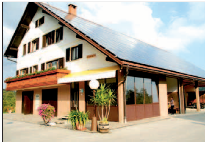
Jugozahodni del strehe je pokrit s 320 fotovoltaičnimi moduli.
