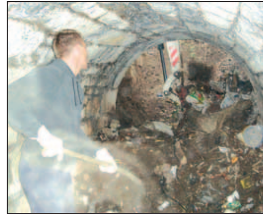
Česar ni zmožal bager, so opravili prostovoljci.
