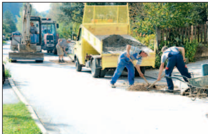
Maroltovi delavci navažajo material in utrjujejo podlago za polaganje asfaltne prevleke na Šolski cesti v Horjulu.
