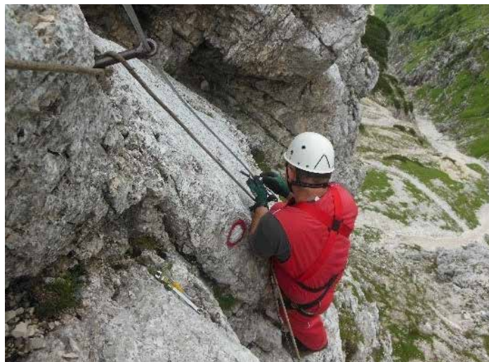
Vgradnja jeklenice. Foto Edo Tomšič
