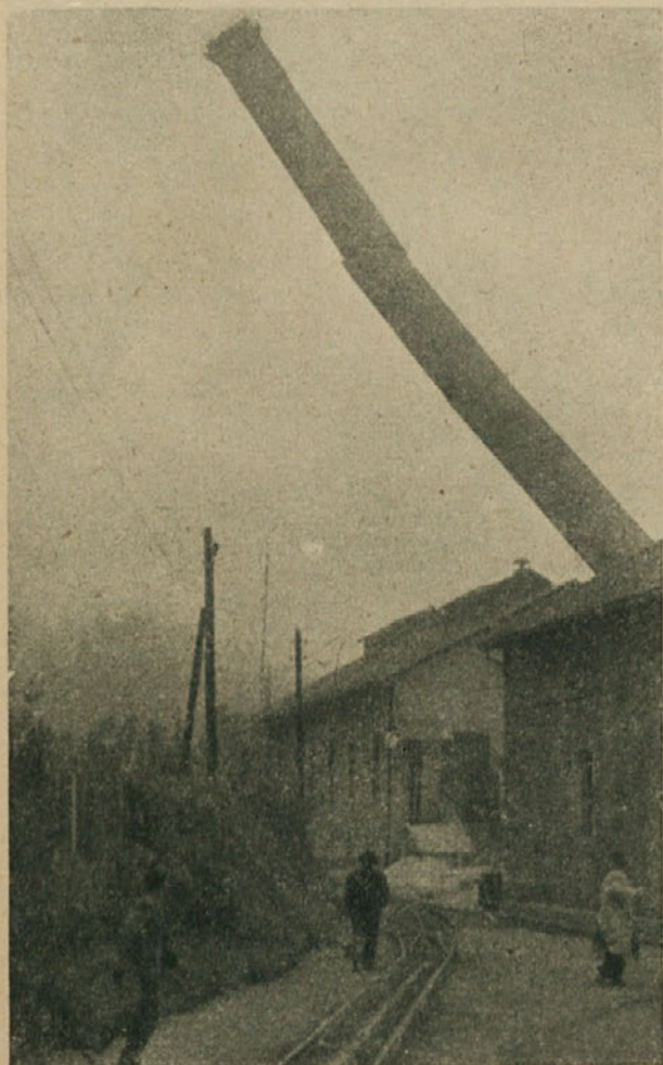
Podiranje tovarniškega dimnika v Zagorju. Fotograf je sprožil kamero ravno v trenutku padanja dimnika, ki se je zaradi zračne sile že v zraku prelomil na 3 dele
