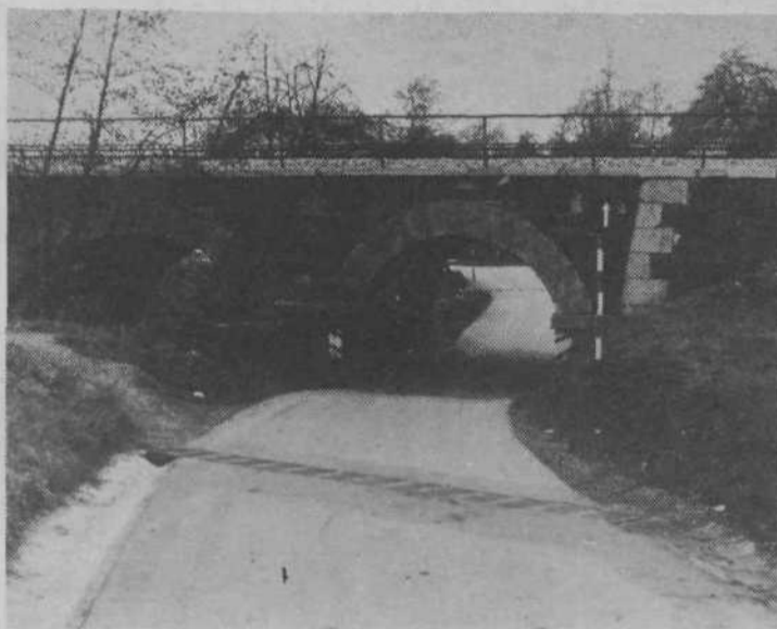
Podvoz v Podgradu, ki je delno že asfaltiran, vendar je zaradi ozkosti in nizkega profila prevoza zelo težko prevozna.
