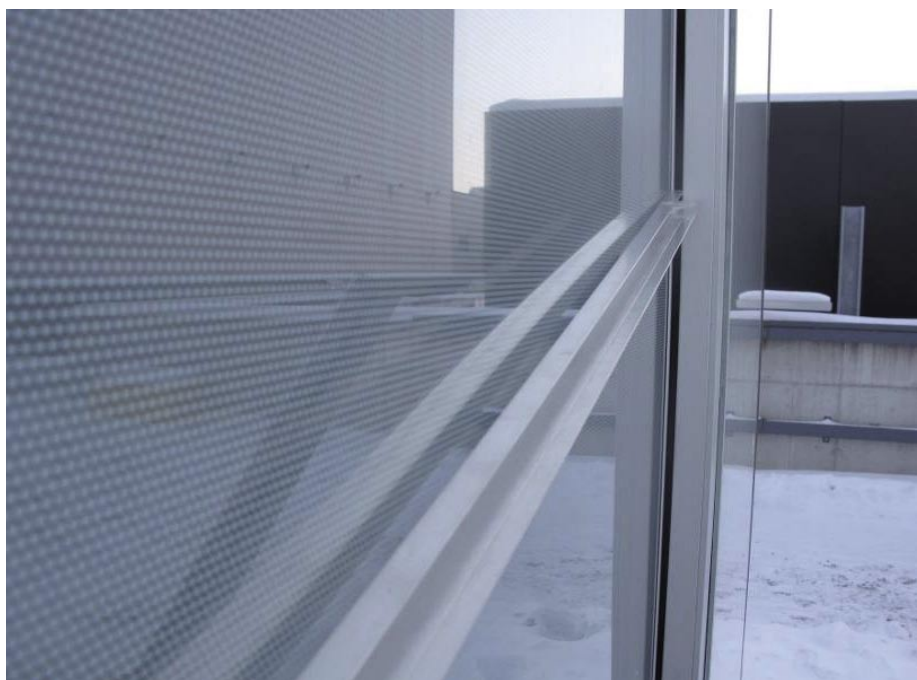
Slika 3 • Primer dvokomornega stekla s 40 mm plinske izolacije pri -20 °C. Zunanje steklo se je vbočilo za več kot 5 mm
