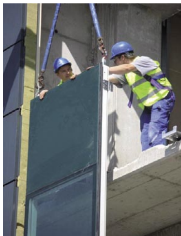
Slika 7 • Primer gradnje s paneli Qbiss Air (QA), ki izkoriščajo 100-milimetrsko razdaljo med zunanjo in notranjo ploščo s strukturno povezavo
