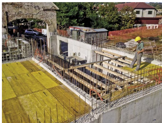
Slika 4 • Opaževanje stropne plošče nad pritličjem prizidka
