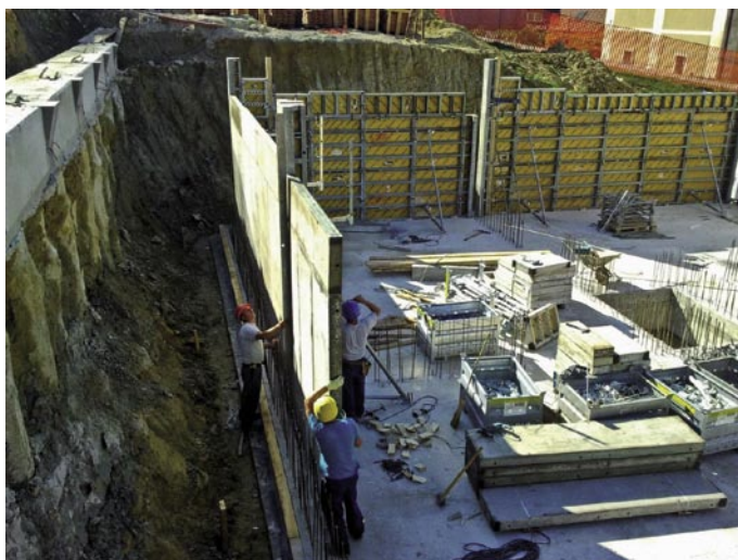
Slika 3 • Pilotna stena, temeljna plošča in opaževanje sten prizidka
