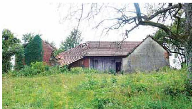
Hiša pred obnovo (foto: P. Kogler)
