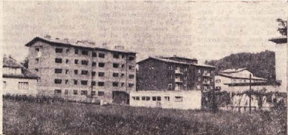
Pogled na skupino novih stanovanjskih blokov na Vidmu; kraj dobiva po zaslugi novega naselja Tovarne celuloze in papirja ter zavoljo vedno novih gradenj iz leta v leto bolj zaokroženo podobo.
