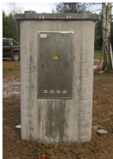
Slika 12: Betoniran krožni temelj in armatura stebra (levo), steber pred izolacijo (sredina), točka kombinirane geodetske mreže v Prilozju po izgradnji in v obratovanju (desno) (vir: GURS, 2014).
