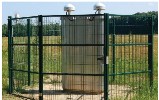
Slika 12: Betoniran krožni temelj in armatura stebra (levo), steber pred izolacijo (sredina), točka kombinirane geodetske mreže v Prilozju po izgradnji in v obratovanju (desno) (vir: GURS, 2014).
