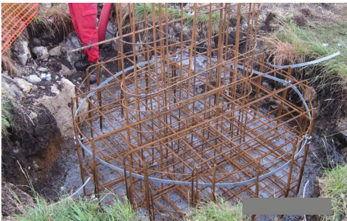
Slika 15: Gradnja točke kombinirane geodetske mreže na Koradi (levo vir: TERRAS, s. p., desno vir: GURS).
