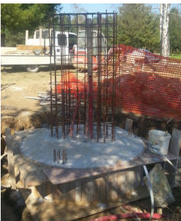
Slika 12: Betoniran krožni temelj in armatura stebra (levo), steber pred izolacijo (sredina), točka kombinirane geodetske mreže v Prilozju po izgradnji in v obratovanju (desno) (vir: GURS, 2014).
