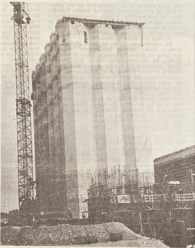
Novi silosi v Ptuj — grajenj z novim načinom opaženja
