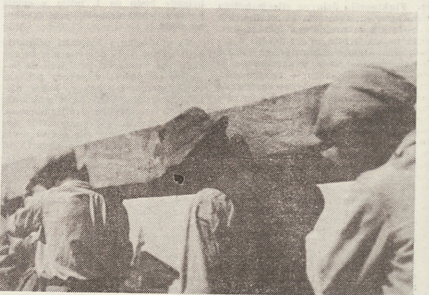
Namesto žerjava so tramove nosili kar na ramah
