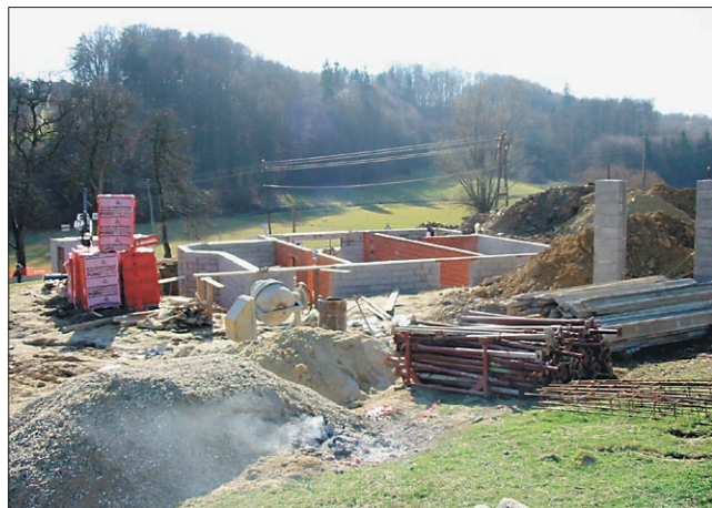
Nova hiša za družino Anželj - Podgoršek je že začela rasti
