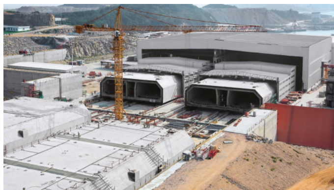
Slika 6 • Izdelane cevi prihajajo iz obrata. (Foto: PERI)
