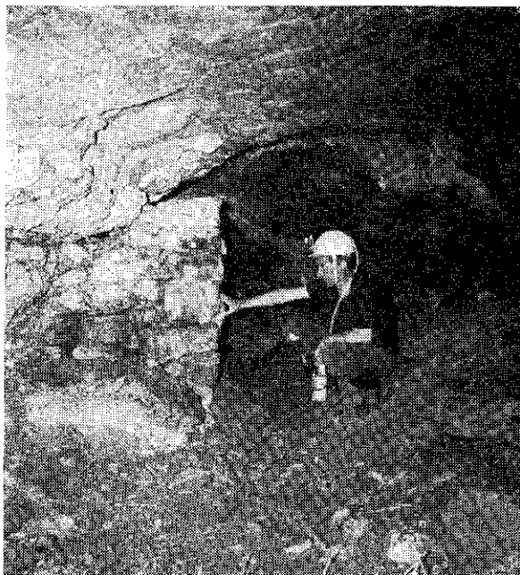
Sl. 3 — Podtaborska jama — notranji zid Fig. 3 — Podtaborska jama — the internal wall
