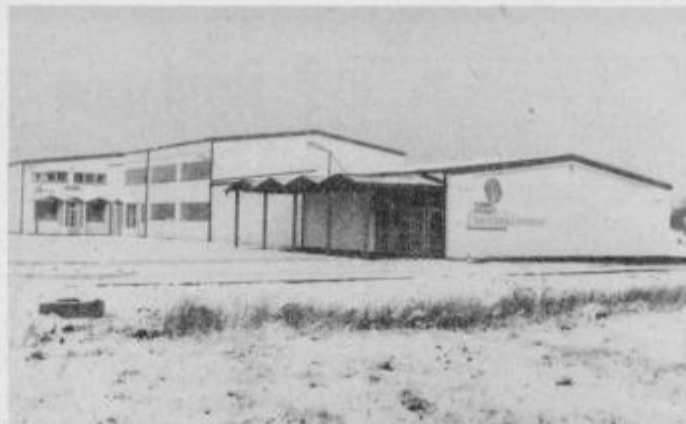
Nakup v novem centru se bo splašal že zaradi cen, kupci pa bodo veseli tudi lepo urejenega parkirnega prostora (Slika: OM)
