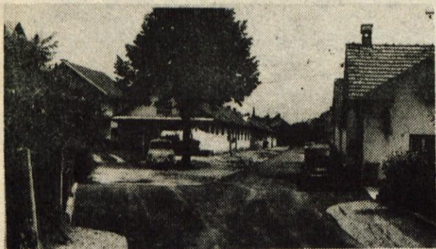
Lesci - V vzhodnem delu Lesci in v naselju Trata so pred nedavnim asfaltirali vse ulice, zdaj pa asfaltirajo ulice tudi v zahodnem delu Lesci in križišče pred solo. Ta teden bodo začeli polagati asfalt tudi v vasi Studensčice. Povsod, kjer so in še bodo položili asfalt v krajevni skupnosti, so prej uredili tudi kanalizacijo. Tako bodo v krajevni skupnosti že letos izpolnili okrog 70 odstotkov srednjeročnega programa del. Program financirajo krajski s samoprispelkom, delovne organizacije, krajevna skupnost in turistično društvo Lesci, ki bo v petih letih prispevalo kar 45 odstotkov vseh sredstev za uresničitve srednjeročnega programa razvoja krajevne skupnosti. - A. Ž. - Foto: F. Perdan
