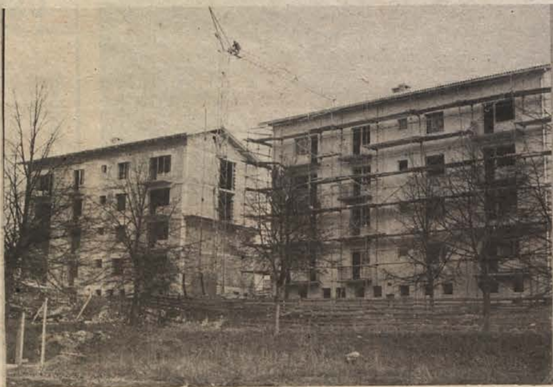
Dva 12-stanovanjska bloka, ki ju je Transportno gradbeno podjetje Metlika zgradilo do te faze v slabih 6 mesecih, čeprav s klasičnim načinom gradnje. Cena kvadratnega metra stanovanja bo 3.900 din. Torej hitra in cenena gradnja.
