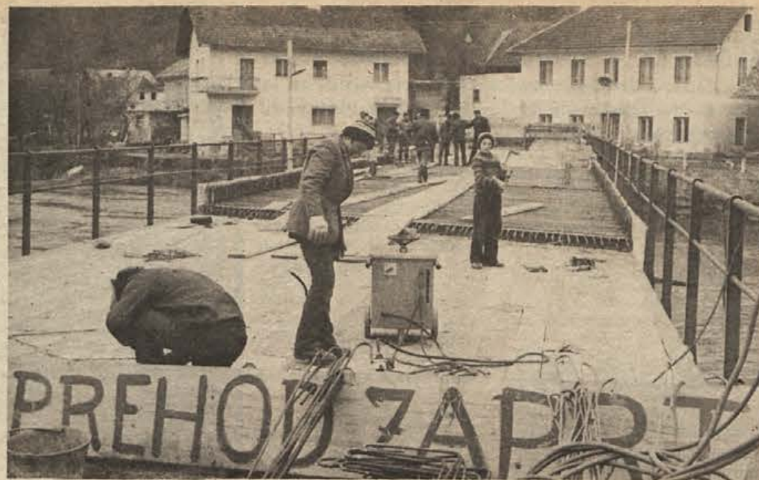
Most čez Krko v Žužemberku so betonirali. Naš dopisnik Milan Senica, sicer tajnik tamkajšnje krajevne skupnosti, je minuli petek dopoldne sporočil, da so betonirali do jutranjih ur tega dne. Most gradijo v reziji krajevne skupnosti, ljudje pa pomagajo s prostovoljnim delom. Posnetek kaže dela na mostu na dan pred betoniranjem. (Foto: I. Zoran)
