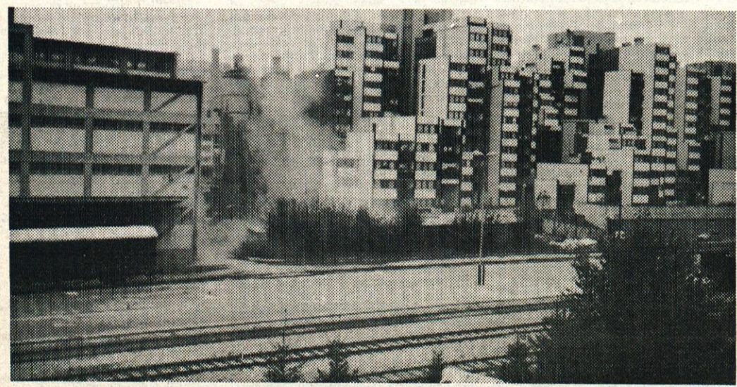
Občani blokov ob železnici so nas opozorili na oblake prahu, ki se večkrat dvigajo iz betonarne, ki tudi sicer močno onesnažuje okolje ob železnici. Kdo in kdaj bo dal betonarno, ki se nahaja v strogem centru mesta na čevlju.
