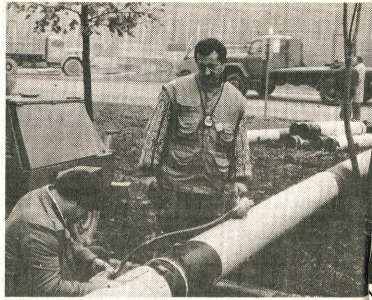
Napeljati bo treba mnogo takih cevi plinovoda, kot so videti te na fotografiji.
