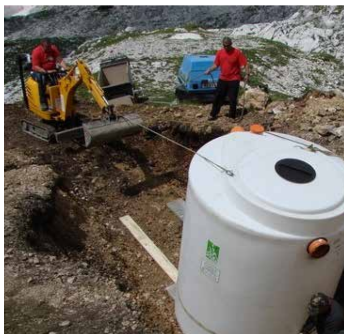
Vgradnja čistilne naprave v gorah predstavlja poseben izziv. Foto Valentin Rezar
