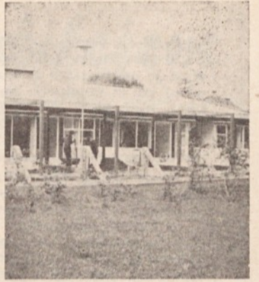
Do konca septembra bo zgrajen in opremljen nov vzgojno varstveni zavod na dvorišču med Kajuhovo in Zakotnikovo ulico. Zavod bo že v oktobru sprejel nad 100 malčkov.
