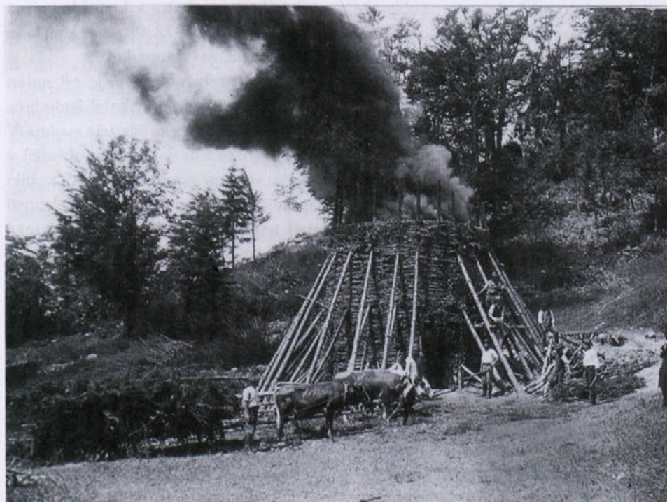
Apnenica v okolici Dolov v začetku dvajsetega stoletja. (Fotografija iz arhiva Sedejevih)
