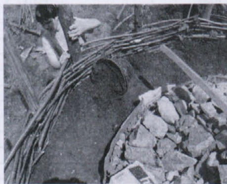
Koli so opleteni z leskovimi palicami, ki tvorijo nekakšno košaro. Prst pa služi kot toplotni izolator in ognjeodporni material. Na sredini je kolobar debelejšega kamenja, z zunanje strani obloženega z drobnim kamenjem. (Foto: Janko Rupnik)
