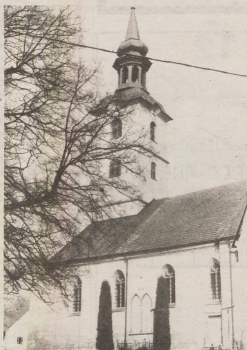
Cerkev sv. Benedikta v Slovenskih goricah potrebuje dobro izolacijo temeljev, sicer bo obnavljanje pročelja zaman. Za ohranitev tega kulturnozgodovinskega in verskega objekta pa so veliko naredili s prekrižjem strehe in ureditvijo stolpa.
