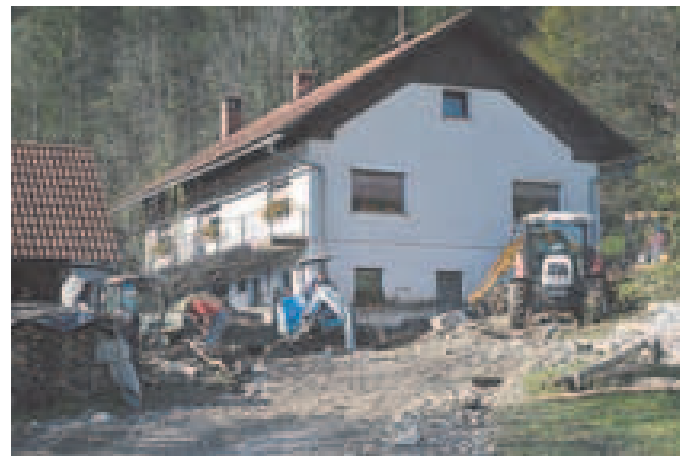
Plaz je zasul tudi stanovanjske hiše - zasuta hiša na Logu pri Hrastenicah.
