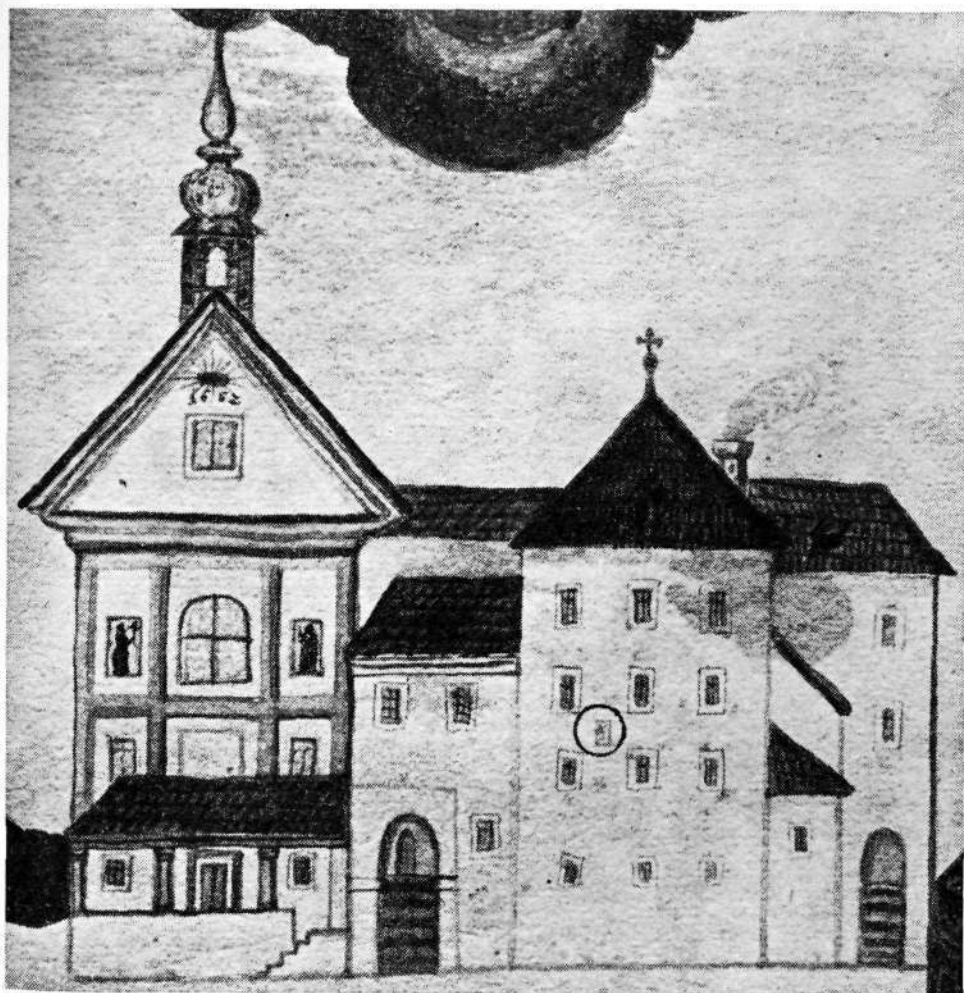
Sl. 4. Pročelje samostana in cerkve iz leta 1652 — detajl
