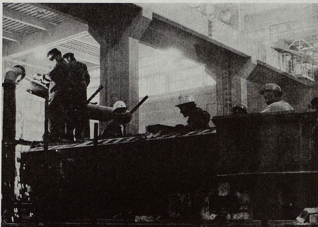
Popravilo katodnega dela
