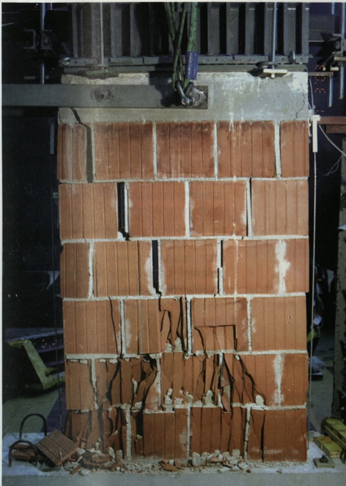
Slika 4 • Krhka lokalna porušitev votlakov pri strižni porušitvi zidov tipa BN
