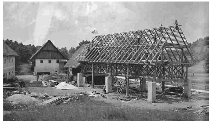
Gradnja kozolca na kmetiji pri Mraku (danes Dole 25). Anton Sedej je sicer pri sovaščanih večkrat vodil gradbena dela, pri tej gradnji pa je objekt zgolj fotografiral (avtor fotografije Anton Sedej, hrani Simon Rupnik).
