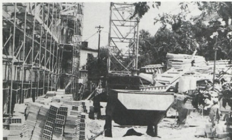
Pogled na gradbišče hotela Metropol v Novem mestu, kjer je vse tako tesno, da še s fotoaparatom težko prideš tako zraven, da bi ujel vso stavbo . . .
