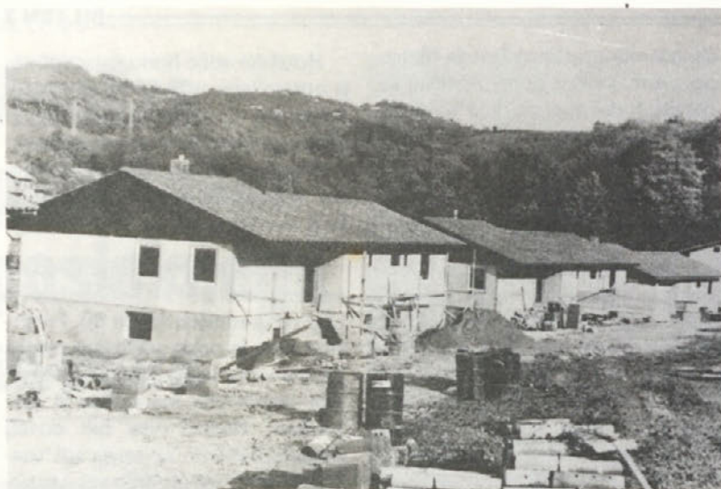
Pri ribniku ob Zdolski cesti v Krškem, gradi TOZD Gradbeni sektor Krško gornje montažne stanovanjske hiše (Foto: GORAN ROVAN)
