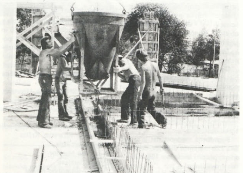
Žerjav je pravkar prinesel na ploščo bodoče kuhinje novomeške bolnišnice keson poln betona
