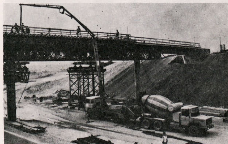
Pri betoniranju mostu na Dravi je v pogonu precej mehanizacije
