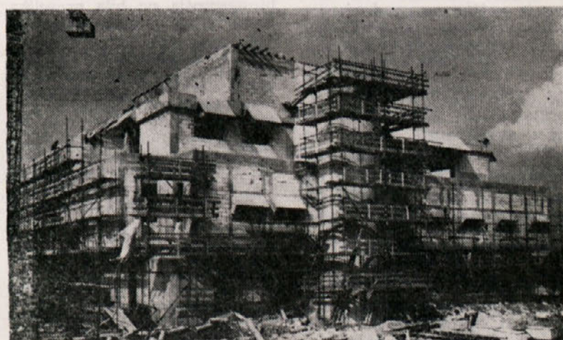
Na objektu blagovne hiše v Žalcu dela z vso naglico napredujejo
