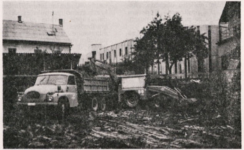
Strojni izkop na objektu samski dom UJV
