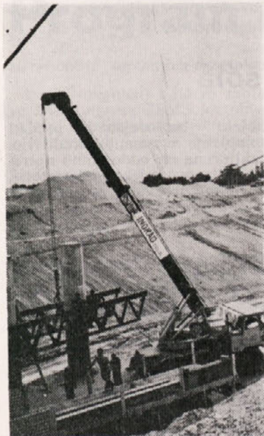
Dvigalo Richier pri montaži mostovne opazne konstrukcije
