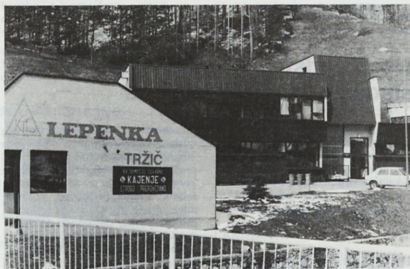
Ne kadite! opozorilo že pri vhodu na tovarniški prostor
