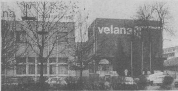
Pol leta novo proizvodno halo mogočni kostanji nekako zakrivajo, ko pa odpade listje, se pokaže pročelje. Foto: J. P.
