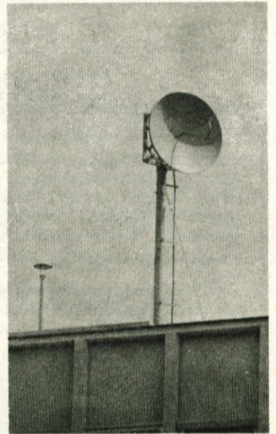
Na domžalski pošti je postavljen nov relejni oddajnik, ki omogoča boljše telefonske zveze z ostalimi kraji
