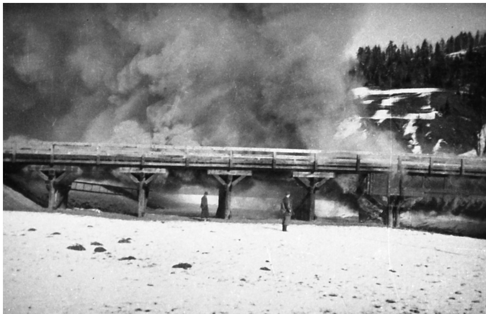
Slika 12: Mostove so vojske rušile, da bi nasprotnikom otežile premike. Tako je jugoslovanska vojska 8. aprila 1941 porušila več mostov: most proti Brekovicam, most, ki je povezoval Stare Žiri s Staro in Novo vasjo ter mostove na Fužinah. Mostove je rušila tudi partizanska vojska. Na fotografiji je most v Žireh, ki ga je požgal Gorenjski odred leta 1943.
