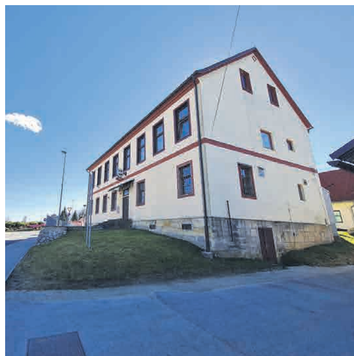
Stavba, v kateri domuje trnovska občinska uprava in je zdaj v celoti v občinski lasti, je nujno potrebna energetska sanacije.
