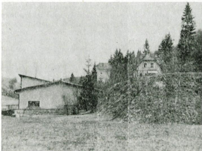
Črpalnica, čistilna naprava, transformatorska postaja in hiša za črpalca v Globočcu
