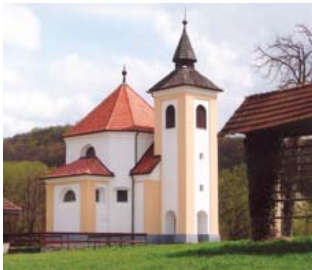
Obnovljena kapela, april 2006.
